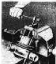
Fig. 10 - Removing the fan
